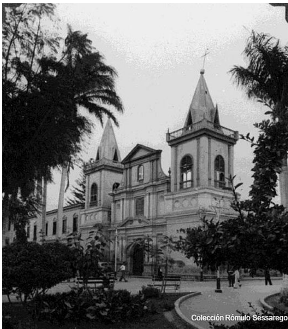
Iglesia de Santa María del Valle de Chiclayo, llamada también "Iglesia Matriz". Tanto el templo como convento franciscano fueron lamentablemente demolidos en la década del sesenta por la Municipalidad para ampliar una calle. Foto: Ricardo Silva Peralta, Colección R. Sessarego.
